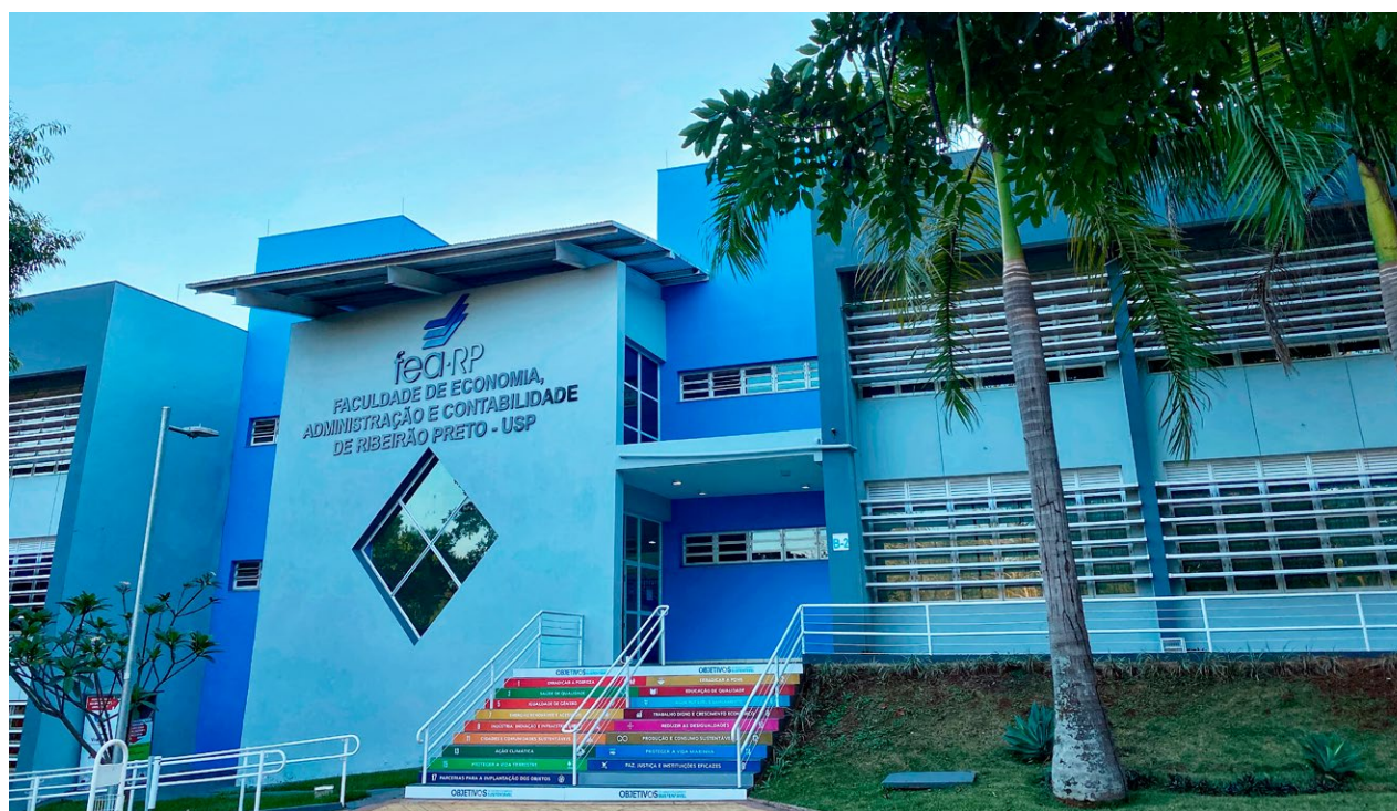
Fachada do Bloco B2
