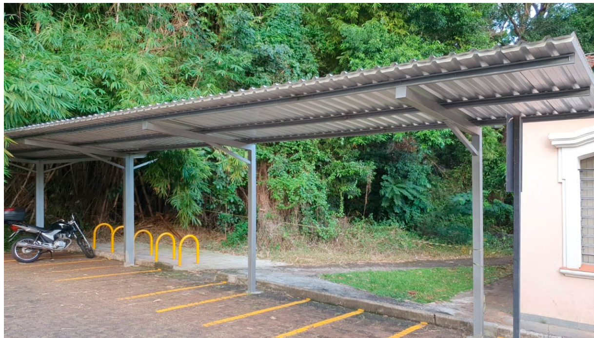
Cobertura no estacionamento
