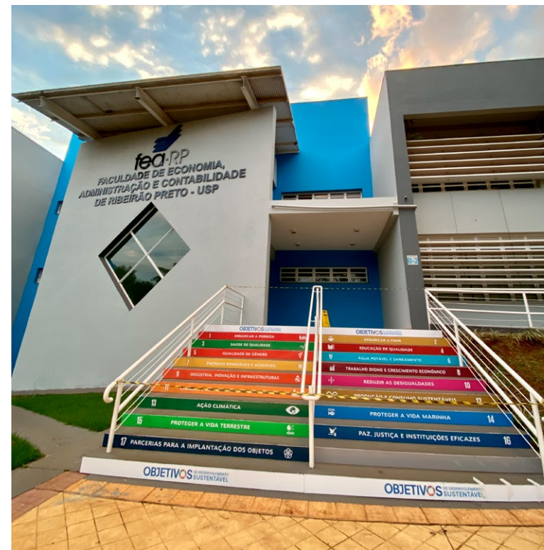
Escadas externas do bloco B2
